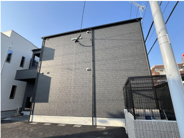
[外観・現況][外観写真]
