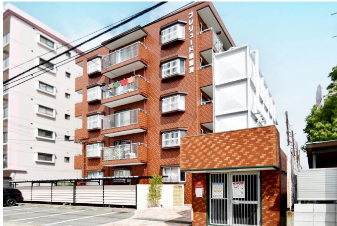
[外観・現況][外観写真]RC造のファミリータイプ物件
