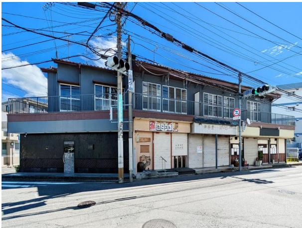
[外観・現況][外観写真]2025年1月外壁塗装工事済
